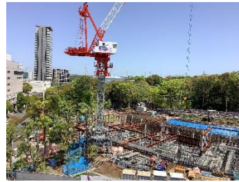
中央図書館の建築が着々と進んでいる。
