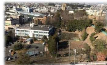
永山駅前にあるUR局舎跡地。旧東永山小学校と当該地を交換し、日本医科大学多摩永山病院の建替え用地として市が準備する。土地交換契約は平成31年3月に行われている。交換差金として180、272千円を多摩市側が負担する。引渡期日は2021年度（令和3年）末を予定。
